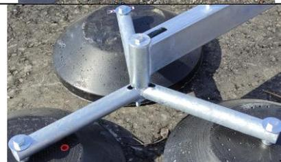
3) Соединить каждую из пяти треног **11** с тремя бетонными основаниями **12** при помощи болтов M16x90 и шайб M16. На каждую треногу предусмотрено по 3 болта и шайбы. Рекомендуется соединять треноги с отверстиями, расположенными по внешнему радиусу бетонных оснований. В зависимости от особенностей площадки возможен монтаж и в центральные отверстия.
